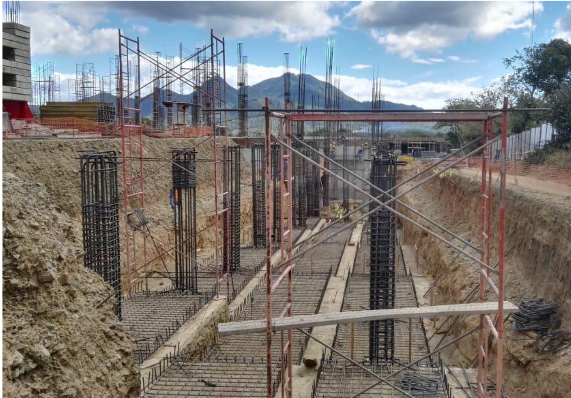
Rampas entre edificio "A" y "B"
