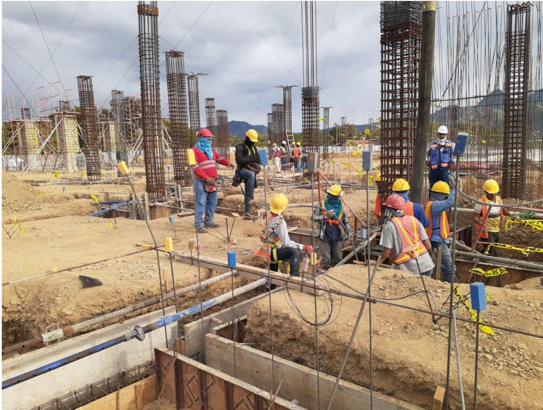
Avances Edificio "F".
